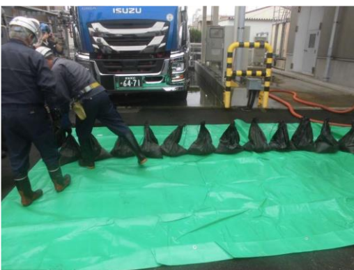
土嚢を並べ漏洩液を塞ぎ止める
