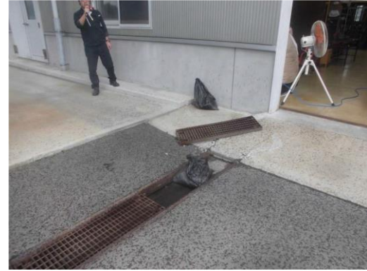
側溝に土嚢を設置し流失するのを防ぐ
