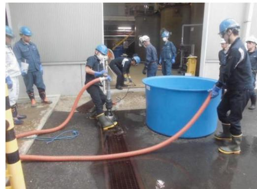
流失した薬液を桶に回収する
